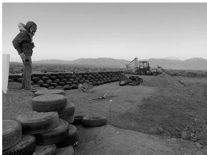
【画像⑥】 廃タイヤとガラス瓶で構築されるAriel Buiのアースシップ
