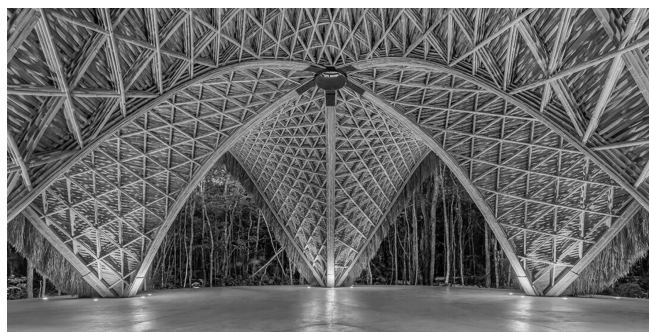
写真⑤ 「Luum Temple」は竹で構築した寺院。設計はジョアナ・ゴメス氏。
