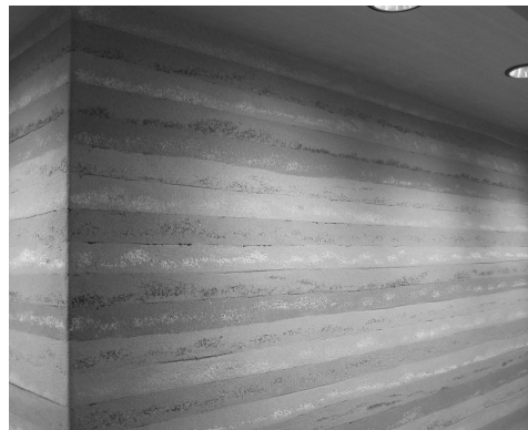
写真③ 商店建築から住宅まで使用例が増えてきた版築(はんちく)風仕上げ
