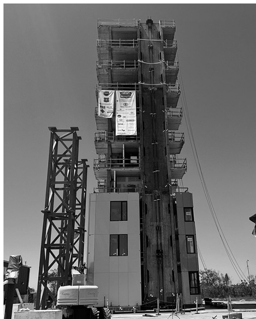
4月から始まった10階建て木造ビル試験体の振動台実験
